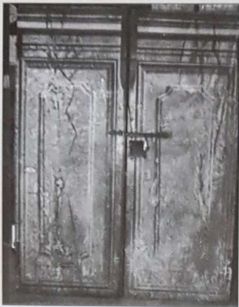
Le portelle di facciata prima del restauro.
