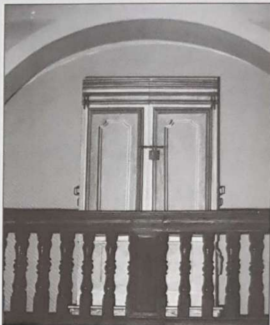
Vista delle portelle di facciata dopo il restauro.
